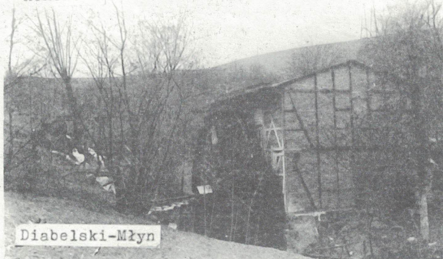
„Diabelski Młyn” – z lewej strony widoczne na rusztowaniu koryto doprowadzające wodę na koło młyńskie.
